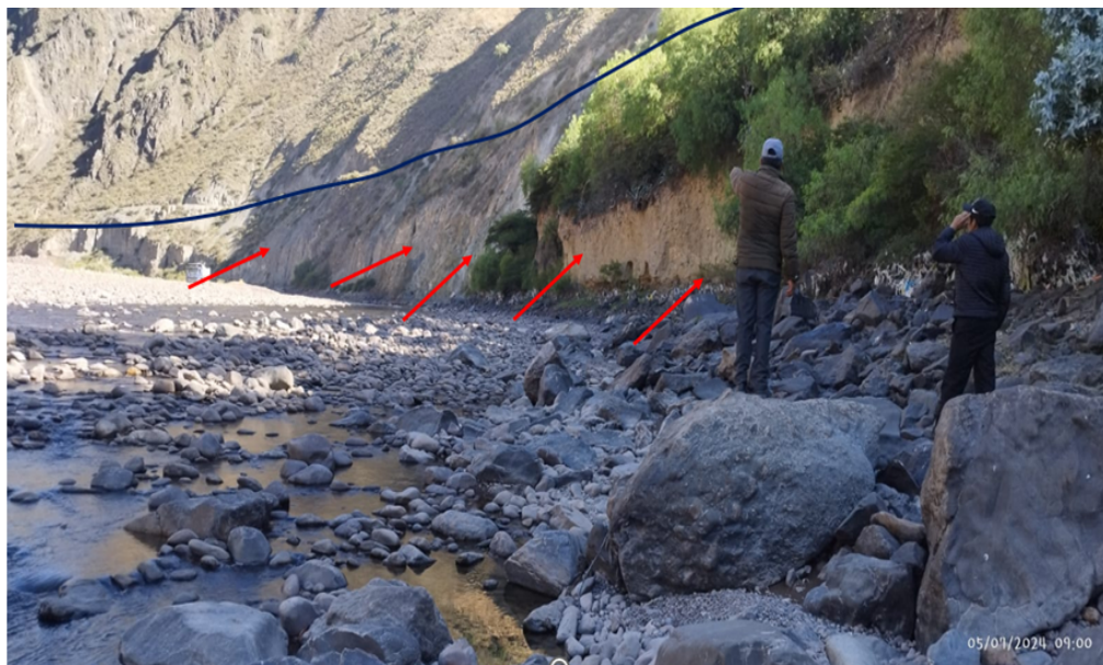
FIGURA N°03: EN LA IMAGEN SE EVIDENCIA SOCABAMIENTO DEL TALUD A CONSECUENCIA DEL AUMENTO DEL CAUDAL DEL RIO MANTARO Y PONIENDO EN RIESGO DE DESLIZAMIENTO Y AFECTANDO LA VIA NACIONAL QUE UNE HUANCAYO A AYACUCHO.
